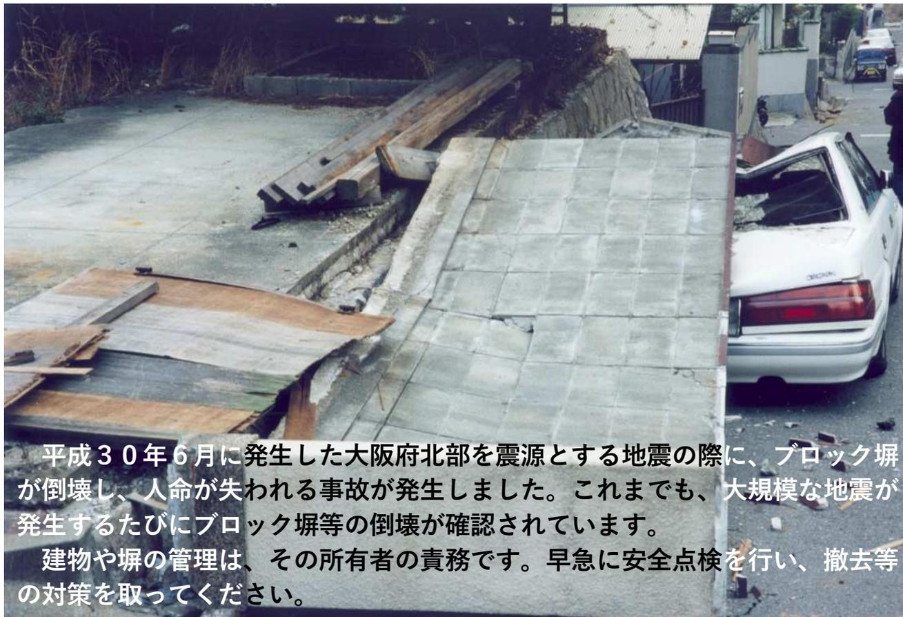
平成30年6月に発生した大阪府北部を震源とする地震の際に、ブロック塀が倒壊し、人命が失われる事故が発生しました。これまでも、大規模な地震が発生するたびにブロック塀等の倒壊が確認されています。
