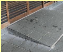
← 段差解消工事
