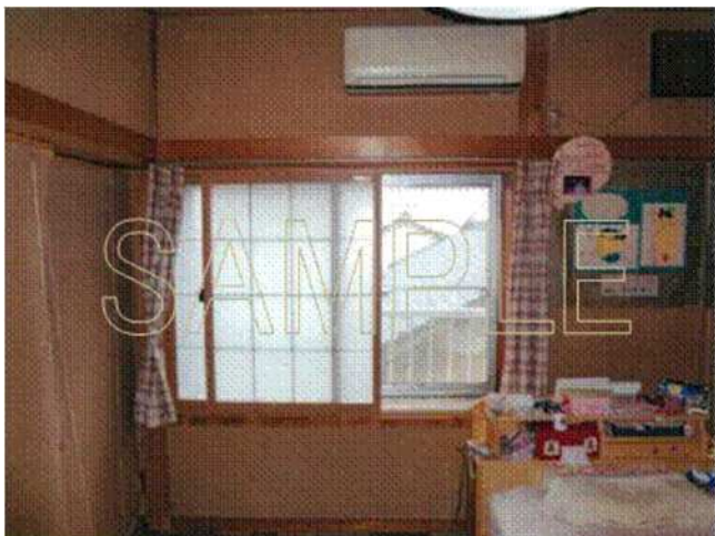
改修後 (内窓設置)
