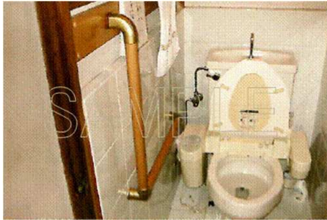
改修後 (便所手摺設置)
